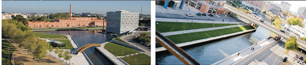
Vista panorâmica do Empreendimento LAKE.
